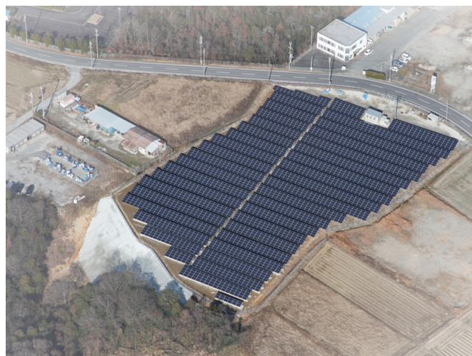
② 兵庫県小野市（発電容量：805キロワット）
